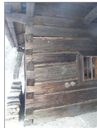
Obr. 6: Jižní stěna Chalupy z Prlova
