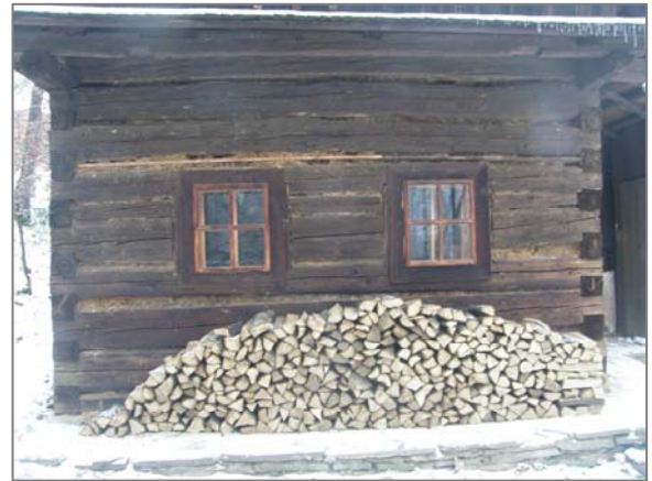
Obr. 4: Západní stěna Chalupy z Prlova
