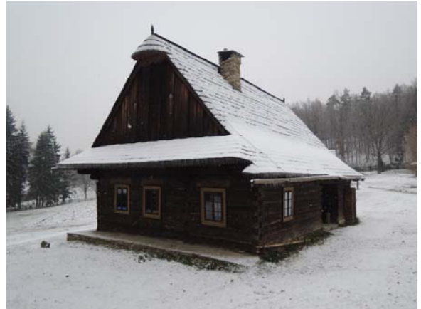
Obr. 2: Šturalova pasekářská usedlost
